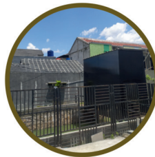
KOLAM RETENSI & POMPA ANTI BANJIR
